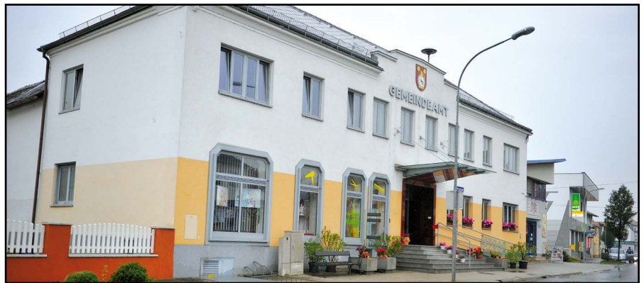
Die Fassade bleibt erhalten, alles andere wird erneuert.
